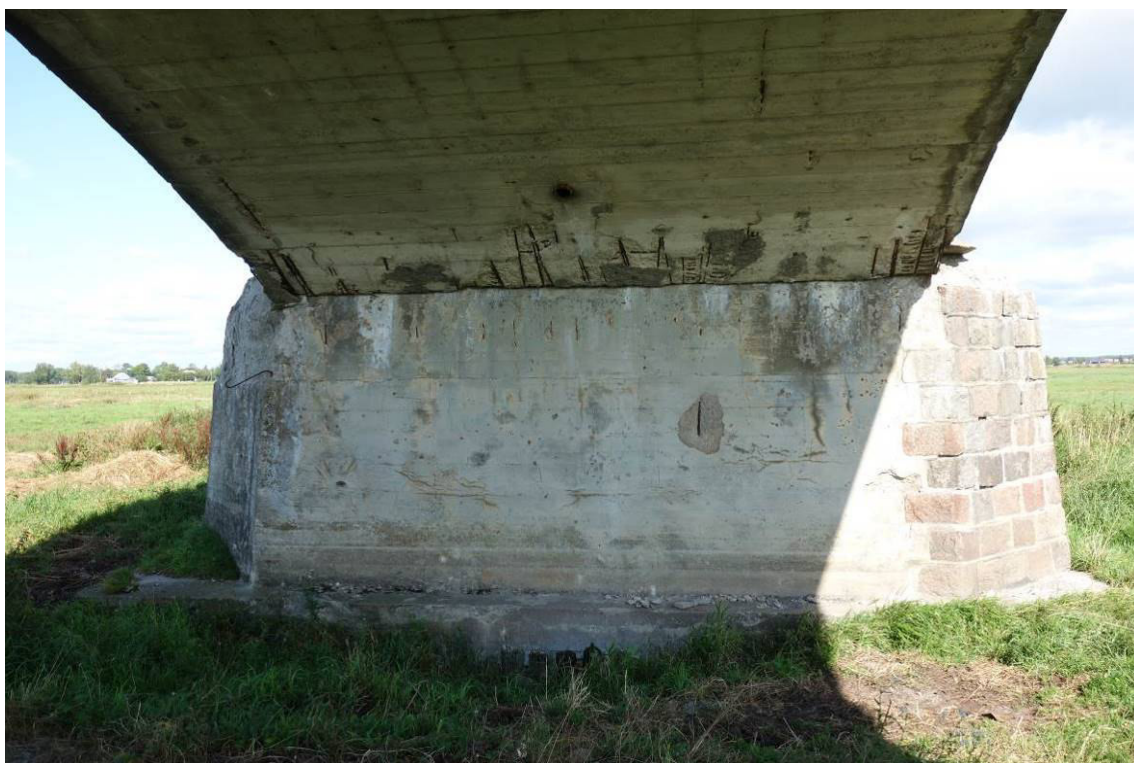
1.7.46 nuotrauka. Dvylikta atrama iš dvylikto tarpatramio pusės. Perdangos armatūros korozija, apirę atramos paviršiai
